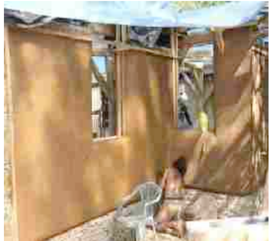
6- La couche de finition est appliquée en intérieur et extérieur
