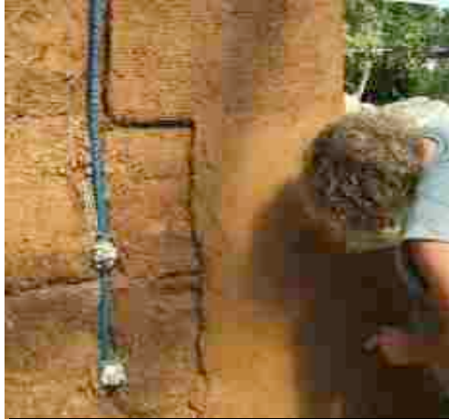
5- Une couche de corps est appliquée en intérieur et extérieur
