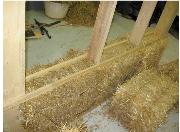
Bottes comprimées entre montants et liteaux
