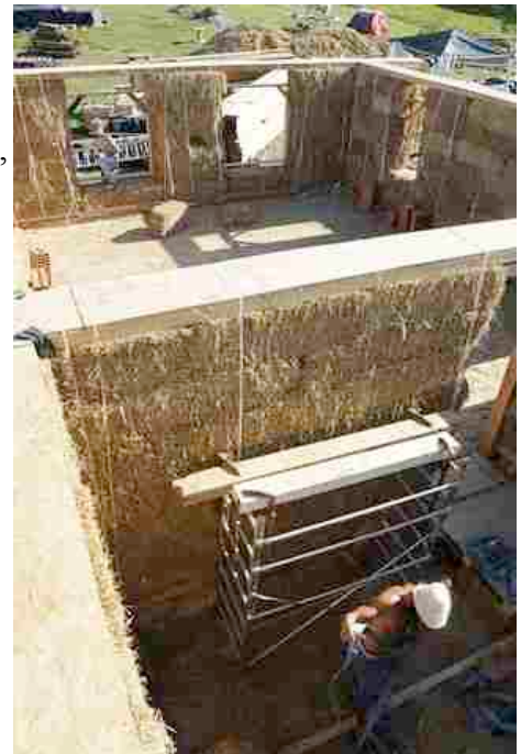
Paille comprimée entre lisse basse et haute
